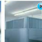
**TopAir-Collection:** Auf dem Foto die AirboxPlus-Ausführung in Verbindung mit einer Wärmepumpe (ohne Abluftanschluss). Sorgt für eine gleichmäßige Luftverteilung in den Raum und verhindert die Kondensatbildung an der Spülküchendecke. Lamellenelemente einfach entfernbar und in der Spülmaschine bequem zu reinigen.
