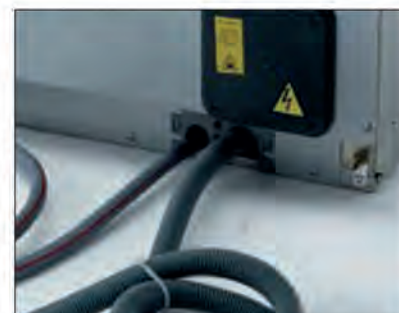
Wasserschlauch mit Metall-Verbindungen, außen liegende Installationsbox
